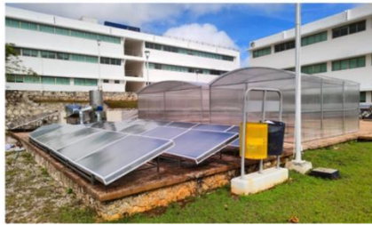
Figura 5. Vista del estado actual de los secadores solares y de los sistemas solares fototérmico y fotovoltaico de la planta de deshidratado de productos pesqueros.
